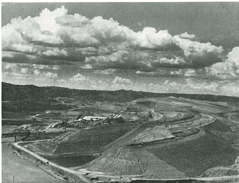
Abb. 1. Blick auf die Baustelle des Mangla-Staudammes in Pakistan.
