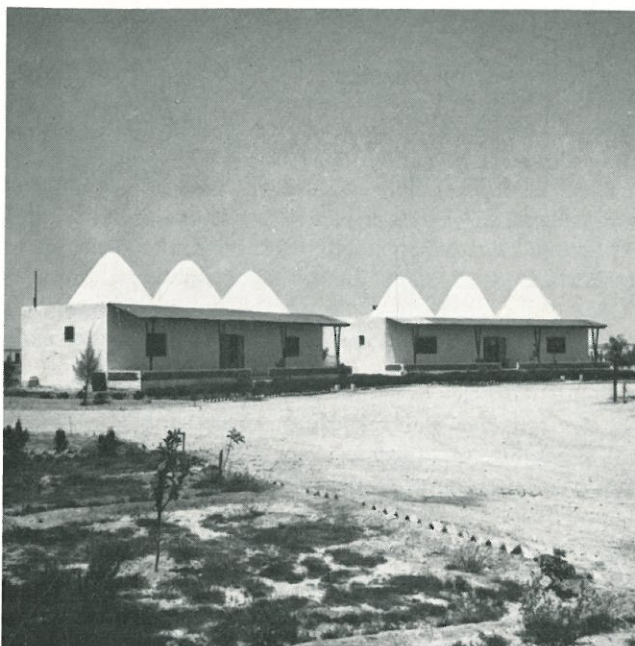
Abb. 3. Moderne, den örtlichen Verhältnissen angepasste Wohnbauten wurden für Beduinen geschaffen, um dadurch einen Anreiz für deren Sesshaftwerdung zu schaffen.
