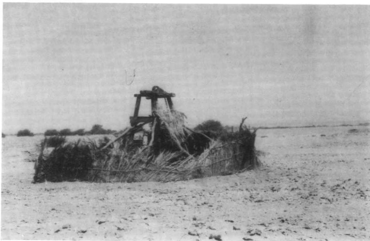
Abb. 3: Bohrstelle mit Bohrgerüst in der Oase Dachel.
