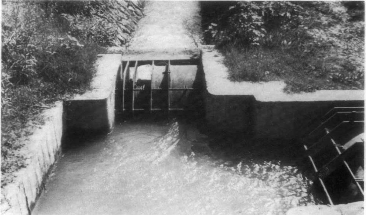
Abbildung 3: Einlaßschleusen für verschiedene Wassermengen in den Zulaufkanal
