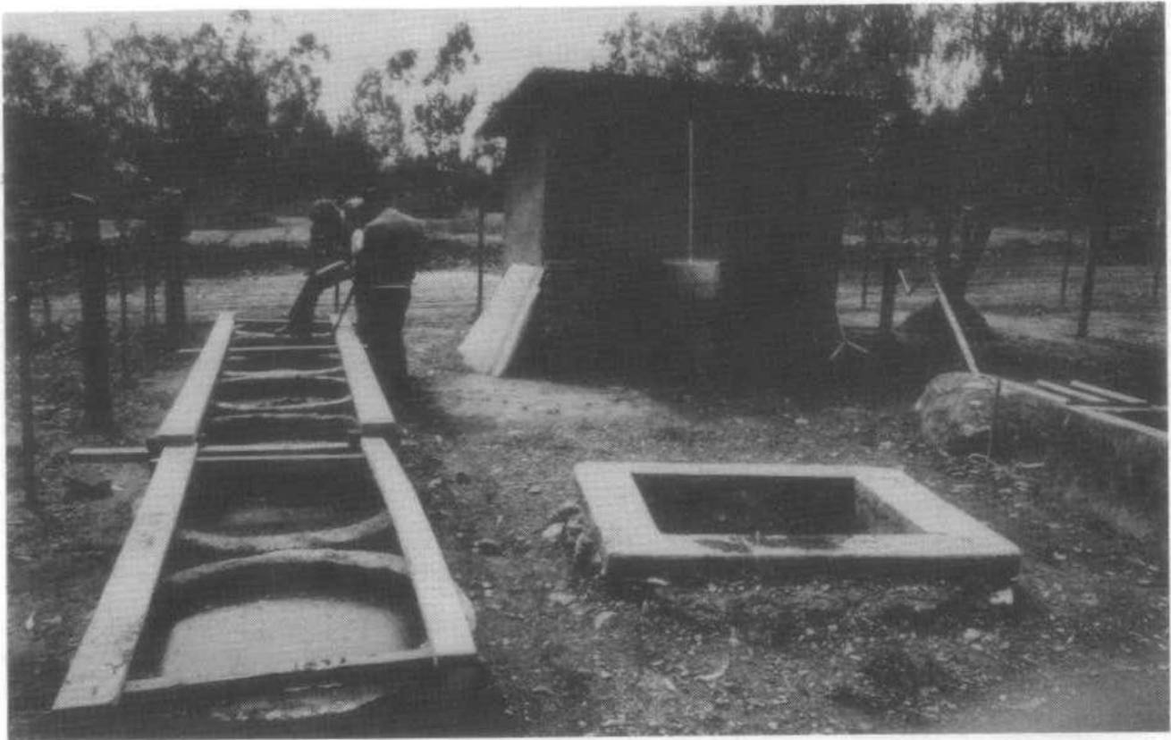
Abb. 9. Biogasanlage für eine Familie in Bolivien konzipiert. Die Behälter sind unterirdisch; am Griff im Vordergrund wird zur Erzeugung des Gases gedreht und so die organische Masse gerührt.
