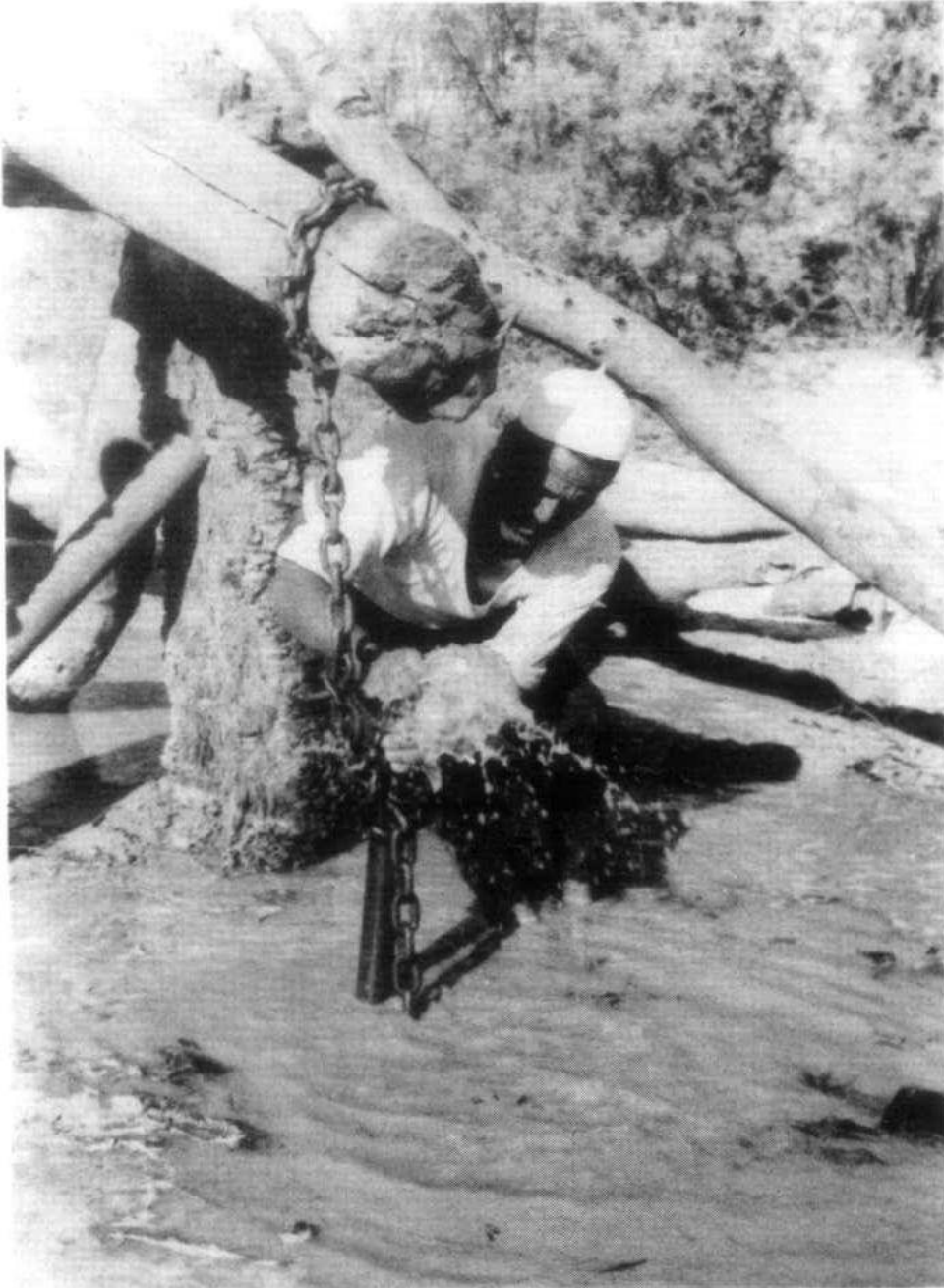
Abb. 2: Brunnenbohren mit arbeitsintensiver einfacher Technologie in Qabalah (Bahriyah-Oase)
